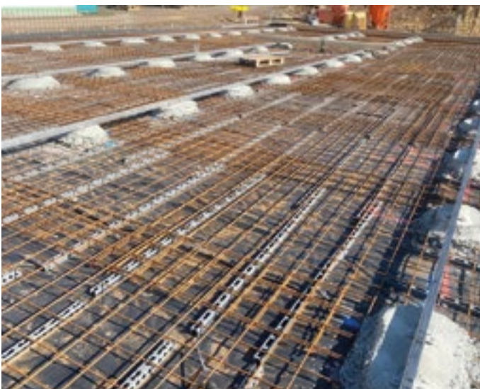
Einbau von U-Führungsschienen für Mistschieber
