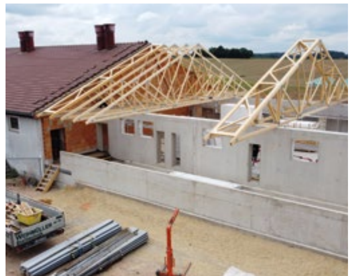
Von Fundament, über Betonarbeiten bis zum Dachstuhl – alles aus einer Hand
